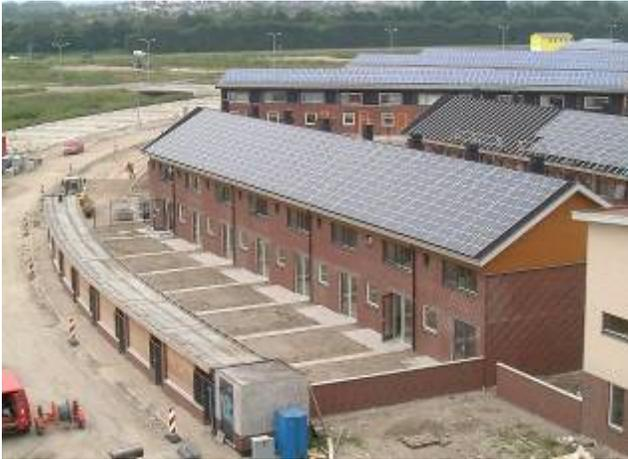
In diesem niederländischen Neubaugenossenschaftsprojekt wurden 50.000 m<sup>2</sup> Photovoltaik-Module auf 2.600 Häusern mit Kawneer-Unterkonstruktion montiert. Auf allen nach Süden ausgerichteten Dächern befinden sich Solarmodule. Je nach Haustyp wurden 40 - 64 Module pro Dach installiert.
